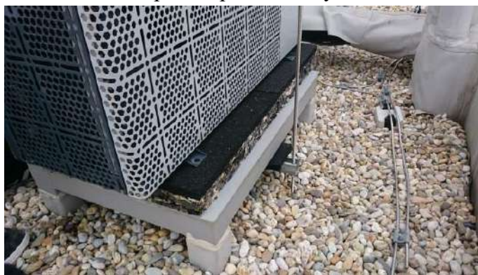
Uloženie tepel. čerpadla na obytného domu
