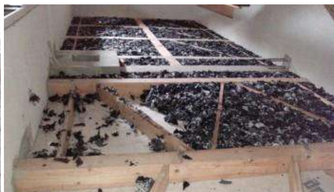
Tepelná izolácia obvodových stien
