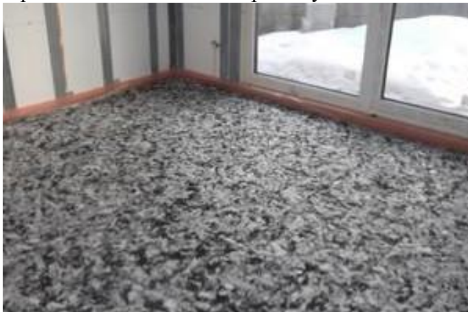
Zateplenie a odhlučnenie priečky
