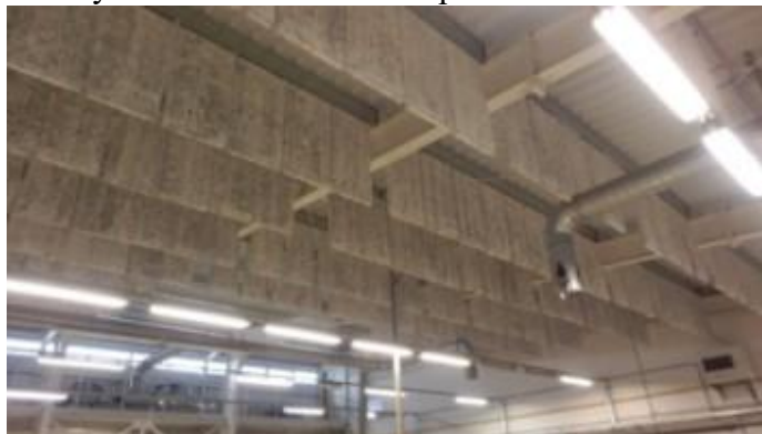
Priemyselná stavba - zníženie pracovného hluku
