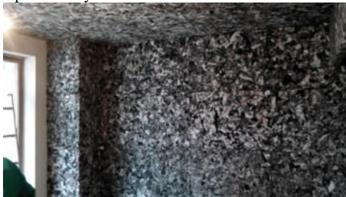
Apartmánový dom – odhlučnenie kotolne
