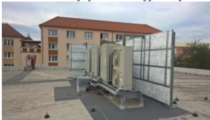
Odhlučnenie vonkajšej klimatizačnej jednotky
