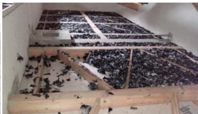
Tepelná izolácia obvodových stien
